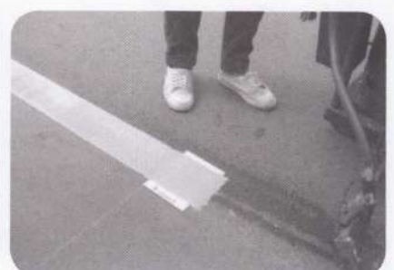
รูปที่ ๓๔ กดแผ่นเหล็กให้อยู่กับที่ขณะทาสิ เมื่อสีแห้งยกแผ่นเหล็กมาตรวจสอบสี ทาสิผ่านแผ่นเหล็กที่วาง
