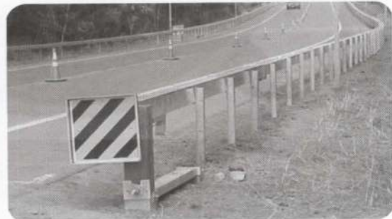
รูปที่ ๕ การติดตั้งราวกันอันตรายแบบกล่องข้างทาง
