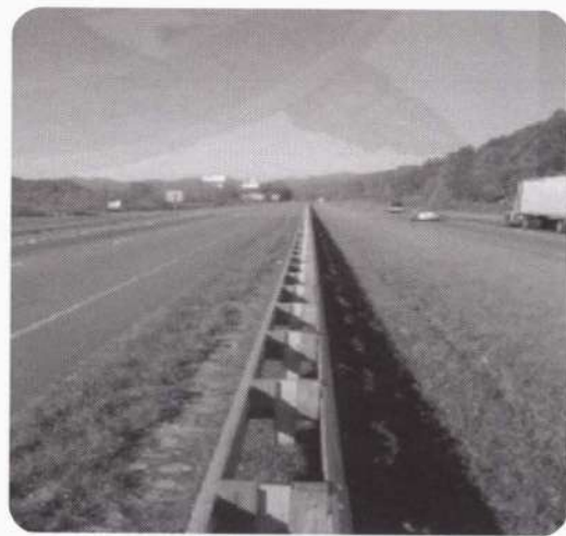
รูปที่ ๖ การติดตั้งราวกันอันตรายแบบรวมเหล็กผูกบนเสาแข็งข้างทางและเกาะกลาง
