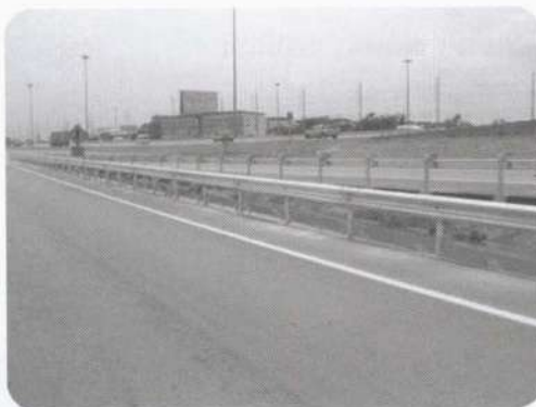
รูปที่ ๒ การติดตั้งราวกันเกาะกลางถนน
