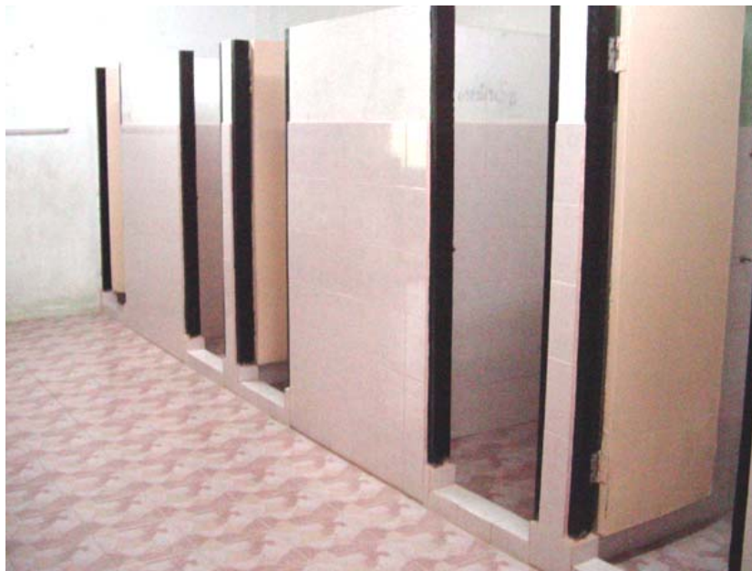
ห้องน้ำที่สร้างอยู่ภายในอาคาร
