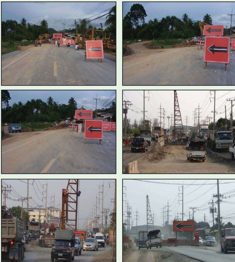
รูปที่ 8-5 การเปียงการจราจร กรณีงานก่อสร้างทางและสะพานเขตชุมชน
