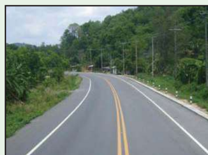
รูปที่ 7-14 สีที่ทาลงบนผิวจราจรจะต้องคงอยู่ และสะท้อนแสงได้ดีภายใต้สภาพการจราจรปกติ ไม่น้อยกว่า 24 เดือน
