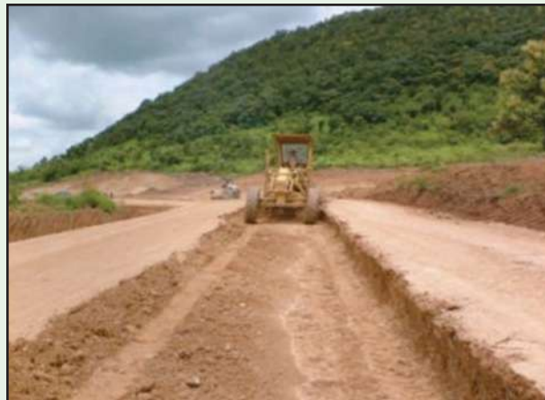
รูปที่ 4-44 ความแน่นไม่ผ่านเกณฑ์ และค่า O.M.C. ไม่อยู่ในช่วง \pm 3 \% ให้รีบลบอัดใหม่
