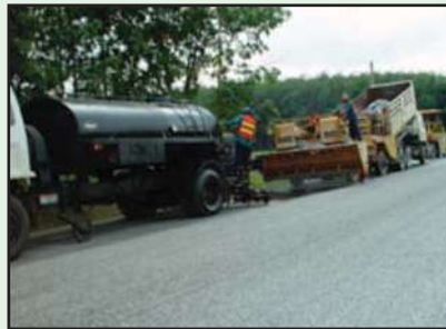
รูปที่ 6-41 ฉีดพ่นยางก่อนโรยหินตามแล้วบดอัด
