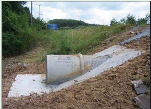
รูปที่ 5-41 หลังจากถอดแบบข้างแล้วให้ปรับดิน โดยรอบให้เสมอผิวคอนกรีต
