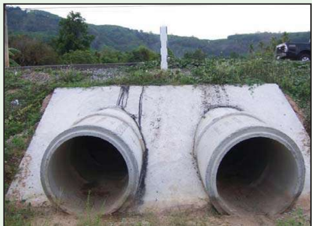
รูปที่ 5-42 หลังจากถอดแบบและปรับระดับดินรอบแผ่นคอนกรีตเรียบร้อยแล้ว ให้ตรวจสอบ เพื่อให้แน่ใจว่าไม่มีการกัดเซาะของน้ำรอบบริเวณแผ่นคอนกรีต
