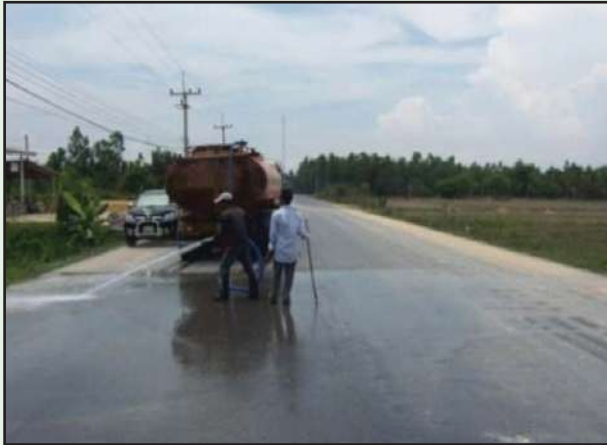
รูปที่ 7-8 การเตรียมการตีเส้นจราจร
