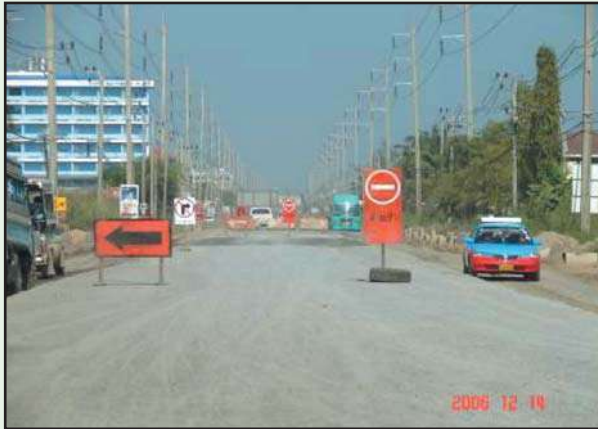
รูปที่ 1 - 3 (ก) การติดตั้งป้ายและสัญญาณควบคุม
