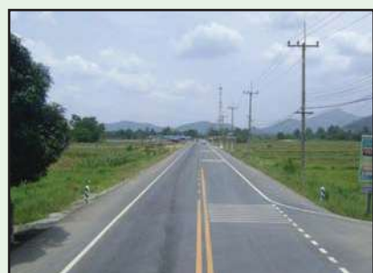
รูปที่ 7-14 สีที่ทาลงบนผิวจราจรจะต้องคงอยู่ และสะท้อนแสงได้ดีภายใต้สภาพการจราจรปกติ ไม่น้อยกว่า 24 เดือน
