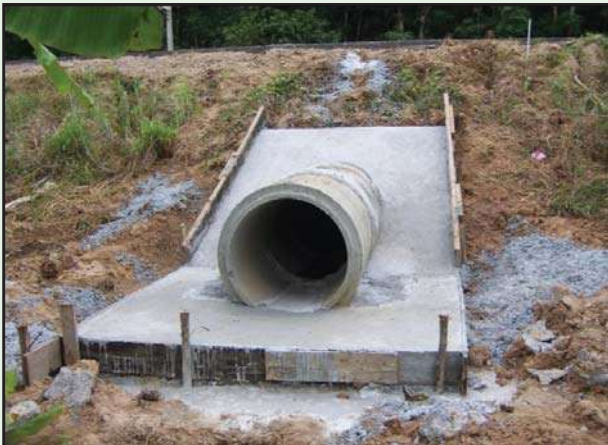
รูปที่ 5-40 กรณีแบบหล่อ (ด้านข้าง) สูงกว่าความหนาคอนกรีตที่เทอาจจะเป็นปัญหา ในการปาดแต่งผิวหน้าคอนกรีต
