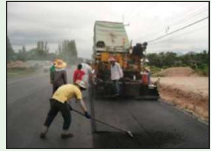
ควบคุมแนวการปู
