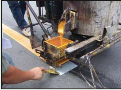
กดแผ่นเหล็กให้อยู่กับที่ขณะทาสี เมื่อสีแห้งยกแผ่นเหล็กมาตรวจสอบสี
