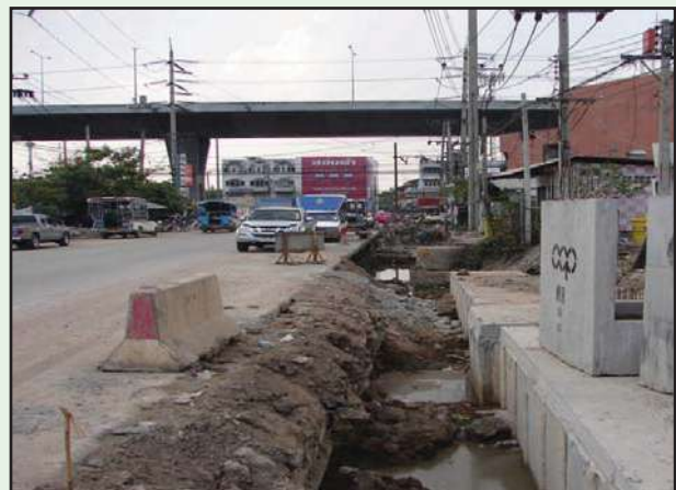
รูปที่ 8-8 การติดตั้งแผงกั้นในพื้นที่ก่อสร้างท่อระบายน้ำทั้งในเขตชุมชน
