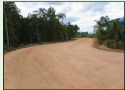
รูปที่ 4-40 ชั้นรองพื้นทางที่เสร็จแล้วต้องมีความเรียบและได้ระดับตามแบบแปลน
