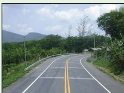
รูปที่ 7-14 สีที่ทาลงบนผิวจราจรจะต้องคงอยู่ และสะท้อนแสงได้ดีภายใต้สภาพการจราจรปกติ ไม่น้อยกว่า 24 เดือน
