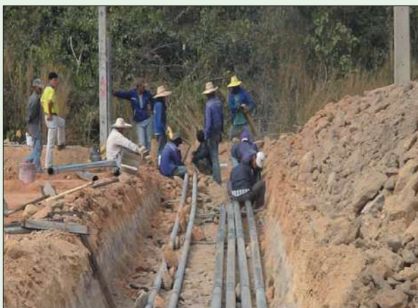
รูปที่ 2 - 1 การขุดขนย้ายสาธารณูปโภค
