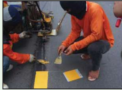
กดแผ่นเหล็กให้อยู่กับที่ขณะทาสี เมื่อสีแห้งยกแผ่นเหล็กมาตรวจสอบสี
