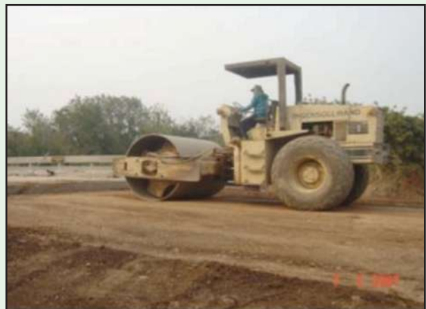
รูปที่ 4-23 การบดอัดบริเวณที่อยู่ใกล้กับโครงสร้าง คสล. ไม่ควรสันสเทือนเนื่องจากจะทำให้โครงสร้างเสียหายได้
