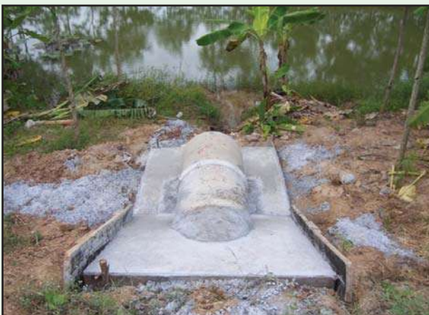
รูปที่ 5-42 หลังจากถอดแบบและปรับระดับดินรอบแผ่นคอนกรีตเรียบร้อยแล้ว ให้ตรวจสอบ เพื่อให้แน่ใจว่าไม่มีการกัดเซาะของน้ำรอบบริเวณแผ่นคอนกรีต
