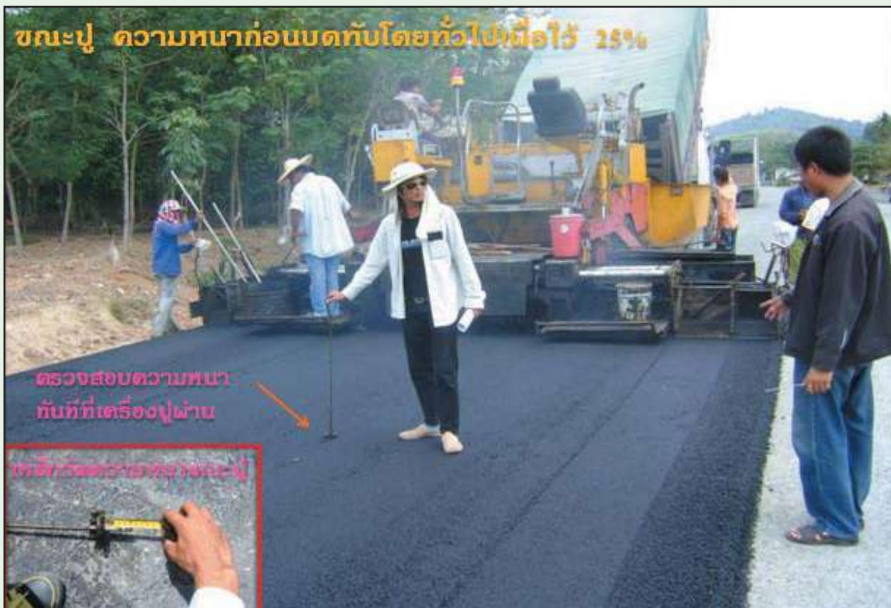
รูปที่ 6-30 แสดงการตรวจสอบความหนาของปูแอสฟัลต์คอนกรีต
