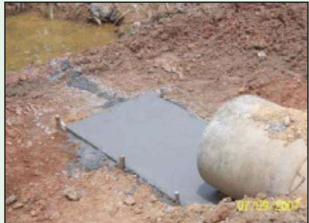
รูปที่ 5-15 การขุดบ่อรวมน้ำ เพื่อระบายน้ำออกจากแนวการวางท่อ
