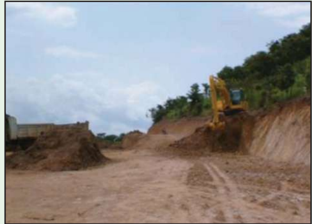
รูปที่ 4-30 การขุดตัดเพื่อก่อสร้างคันทางให้ได้ระดับ
