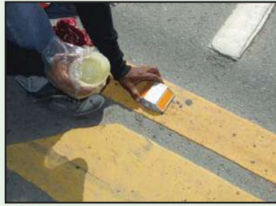
รูปที่ 7-6 รูปแสดงการติดตั้งหมุดสะท้อนแสง
