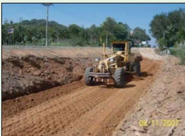
รูปที่ 4-15 ขุดคุ้ย (Scarify) พื้นทางเดิม
