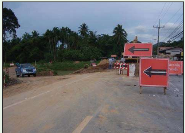
รูปที่ 5-19 แสดงการติดป้ายเตือนและไฟฟ้าแสงสว่างที่บริเวณก่อสร้าง
