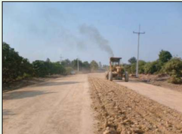
รูปที่ 4-34 การชดช้อยวัสดุ (Scarify) เพื่อทำการบดอัดใหม่ ในกรณีความแน่นไม่ผ่านเกณฑ์
